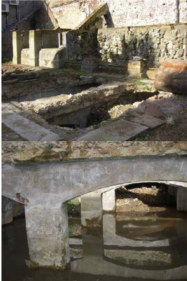
Het Crystal Palace en zijn aquarium waren in hun tijd een opmerkelijk staaltechniek. Bovenste afbeelding: De ruïnes van het aquarium, met twee kleinere aquaria die gedeeltelijk intact zijn aan de linkerkant, en een groot aquarium dat bekend staat als 18a in het midden en rechts. Let op de stenen die in het achterpaneel van het aquarium zijn gecementeerd, die waarschijnlijk als decoratie hebben gediend. De gaten in de vloer leggen het enorme reservoir bloot, dat ooit meer dan 100.000 imperiale gallons zeewater bevatte. Onderste afbeelding: Gedetailleerd aanzicht van het stuwmeer. Afbeeldingen door Tux-t-pinguin, Deviantart.com.
