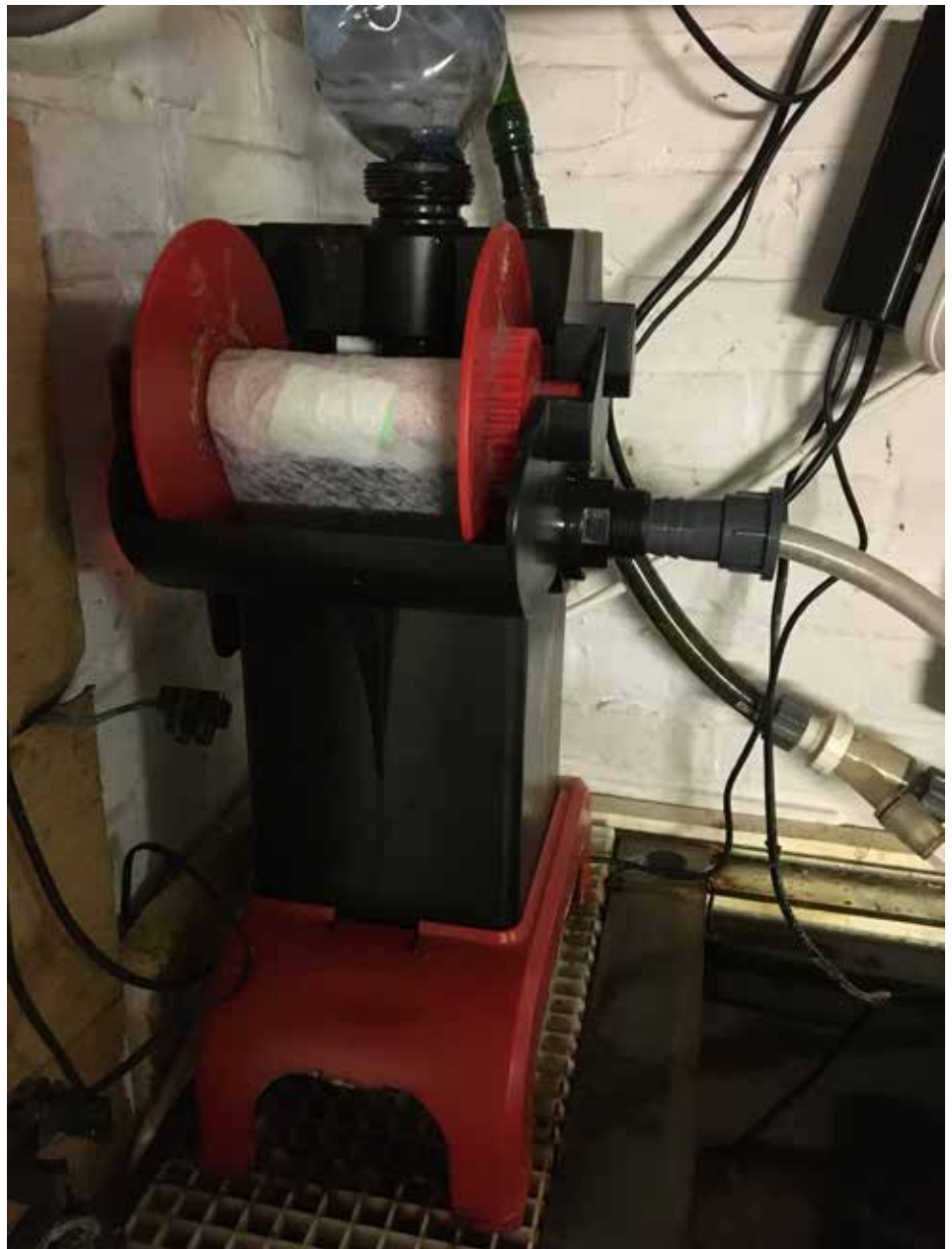
Er werd een nieuwe rol geplaatst
