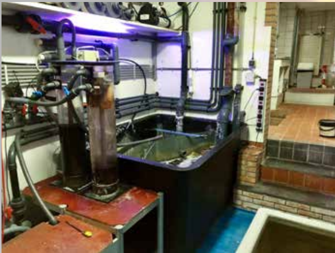
De technische ruimte
