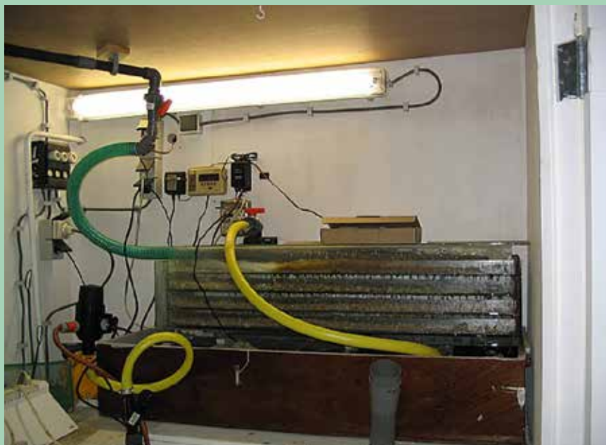
Droog/nat filter, één van de principes van de Berlijnse methode. Foto: ReefSecrets
