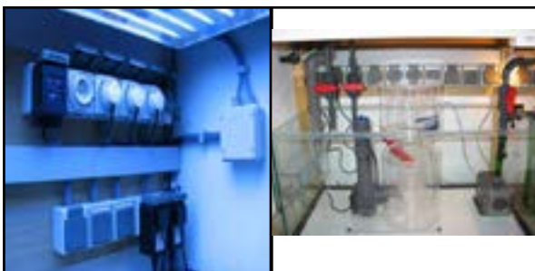
Spatwaterdichte stopcontacten onder en boven het aquarium
